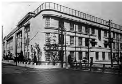
震災復興後の鉄筋コンクリート三階建て校舎 昭和4年竣工・現在地に移転した 昭和48年、現校舎に生まれ変わる
